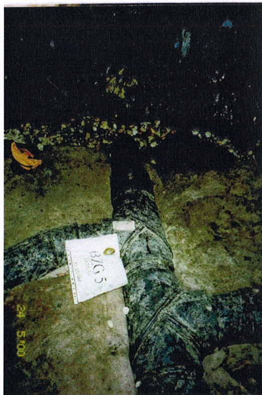
Bild 2: Anschluss der Sauger an den Sickerwassersammler
