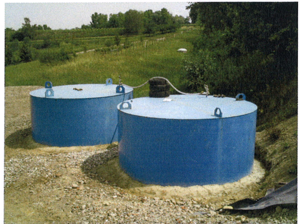
Bild 2: Arbeitstägliche Abdichtung, hier: mit Absaugung des Tandemschachtes zur Emissionsvermeidung
