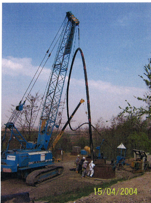
Bild 1: Einzug Rohrleitung beim Berstlining
