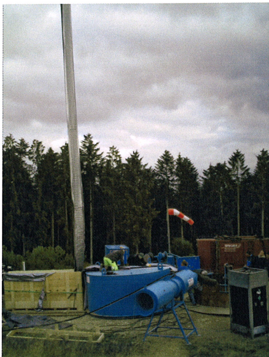
Bild 1: Einzug Schlauchliner im Tandemschacht
