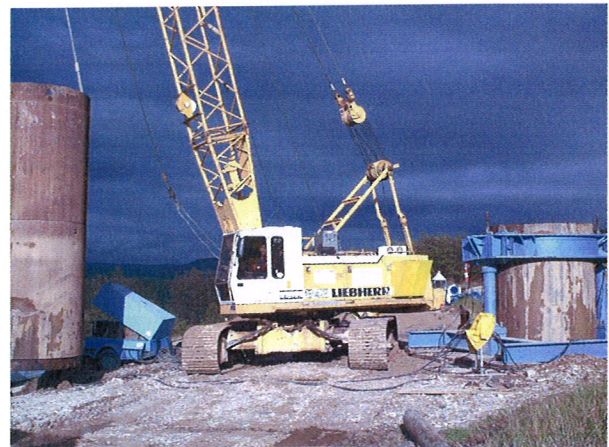
Bild 2: Rückbau Stahlrohrverbau
