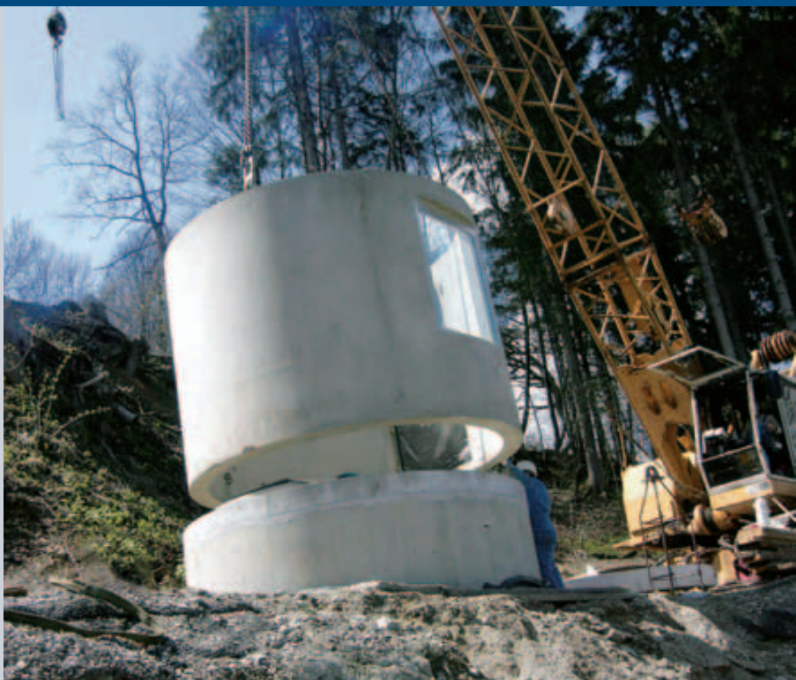
Aufsetzen des Schachtab schlusses beim Horizontalfilterbrunnen
