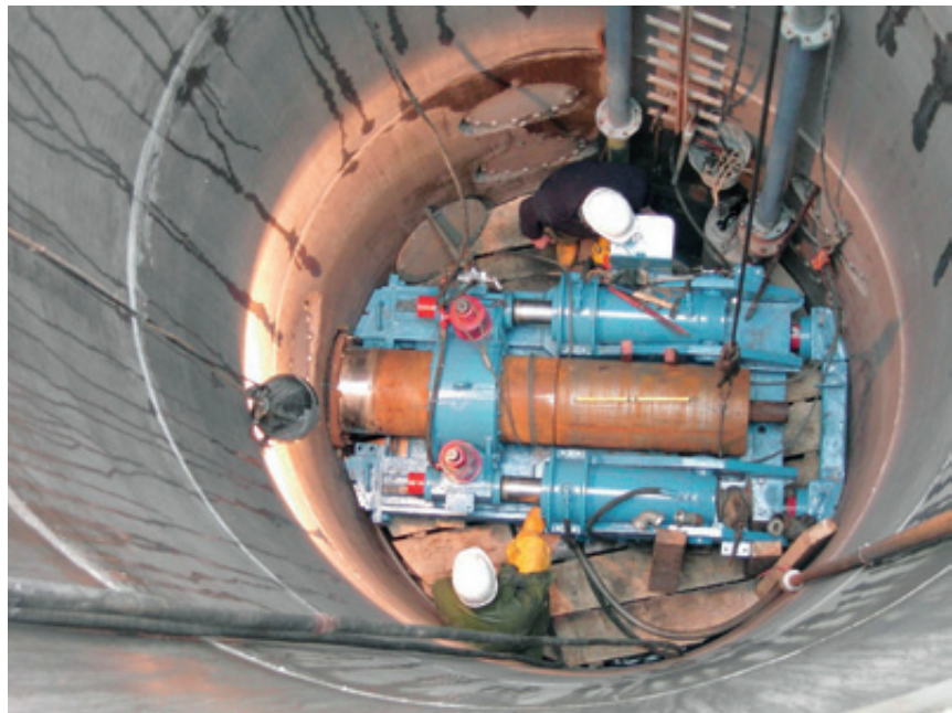
Abb. 5 Blick auf das Horizontalbohrgerät beim Vortrieb
